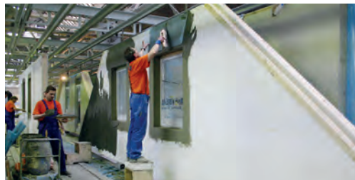
5. V hale osádzame aj okná a dokončujeme zateplenie stien a stierky
