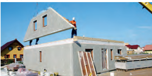
10. Popoludní začíname umiestňovať steny prvého podlažia
