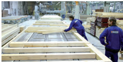
2. Podľa výkresov domu sa na linke poskladá stena domu
