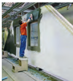
3. okná a fasáda v hale
