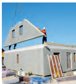
4. montáž na stavbe
