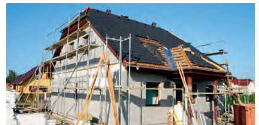
12. Ďalší deň dokončíme strechu a dom je po 3 dňoch na pohľad zvonku hotový a do 30 dní dokončený na kľúč!
