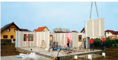
7. Montáž začíname skoro ráno, aby bol dom čo najskôr pod strechou
