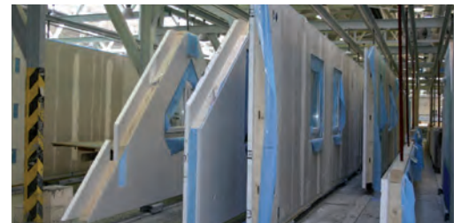
6. Hotové steny čakajú na naloženie a dovoz na stavbu. Podobne pripravujeme aj stropné panely
