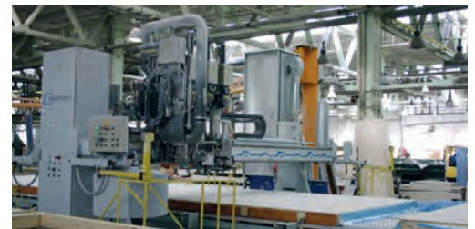
3. automatická linka následne pripevní opláštenie steny z Fermacellu
